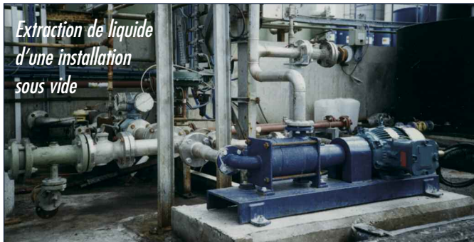
Vidange de puisard et de fosse de rétention de produits chimiques
